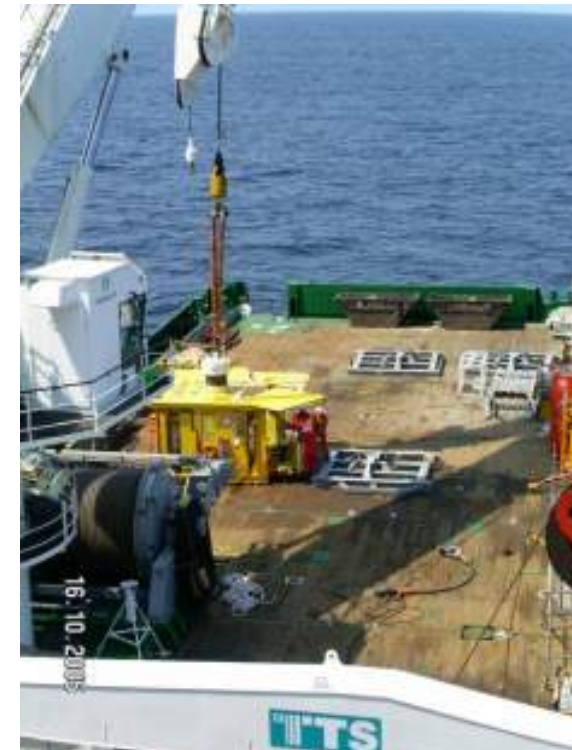
Installation d'une tête de puit
