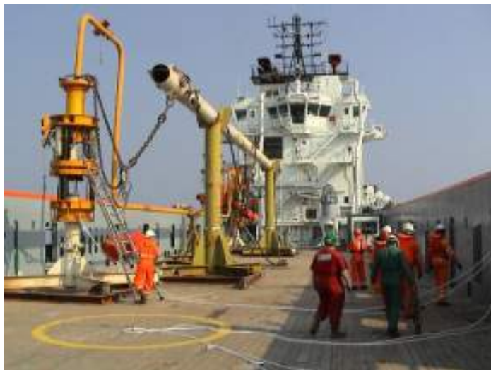
Installation d'un jumper
